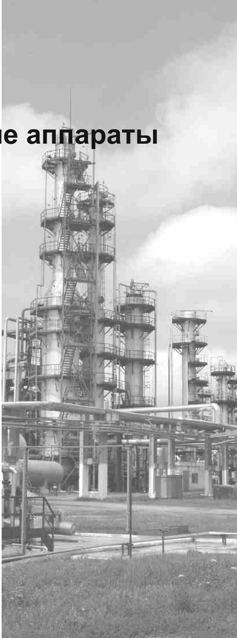
Колонные аппараты предназначены для проведения процессов тепломассообмена: ректификация, абсорбция, дистилляция, адсорбция и т.д. в различных отраслях промышленности.
